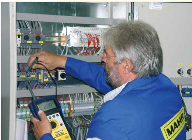
Wartungsarbeiten an einer Heizungsanlage
